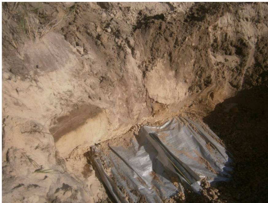
Рис. 4.2 Початок протягування труби зрошувача разом із протифільтраційним екраном
