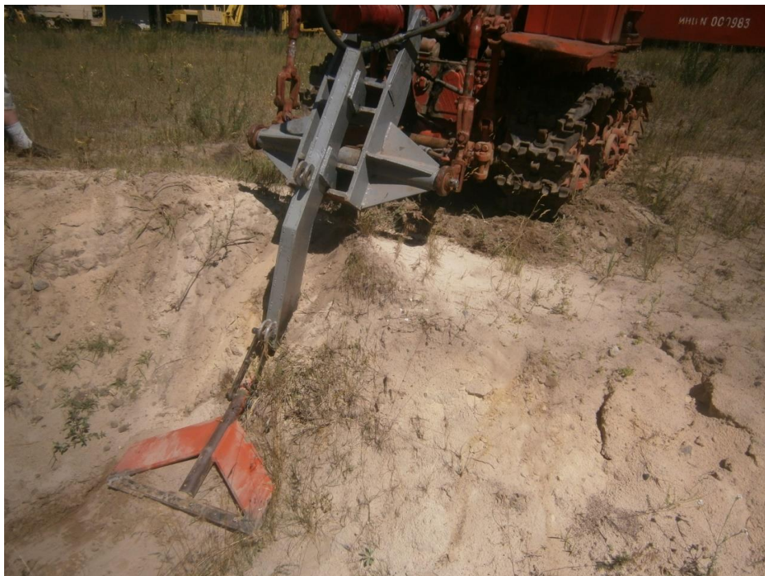
Рис. 3.5 Агрегат, підготовлений до протягнення робочого органу без труби зрошувача та протифільтраційного екрана
