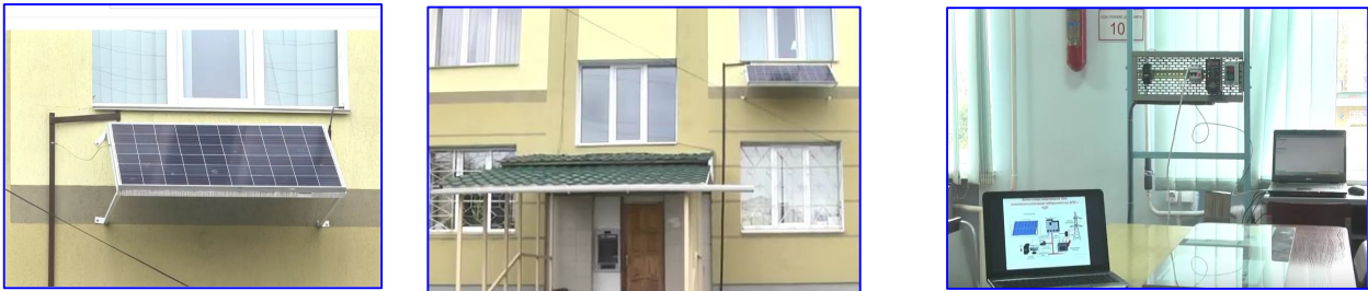
Рис. 2. Зовнішній вигляд сонячної панелі і місце встановлення та підключення вимірювальної апаратури
