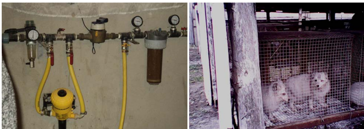
Рис 2. Автоматизована система знезараження, очистки та подачі води питної у шеди для товарного молодняку псаця блакитного (літня питна система)
