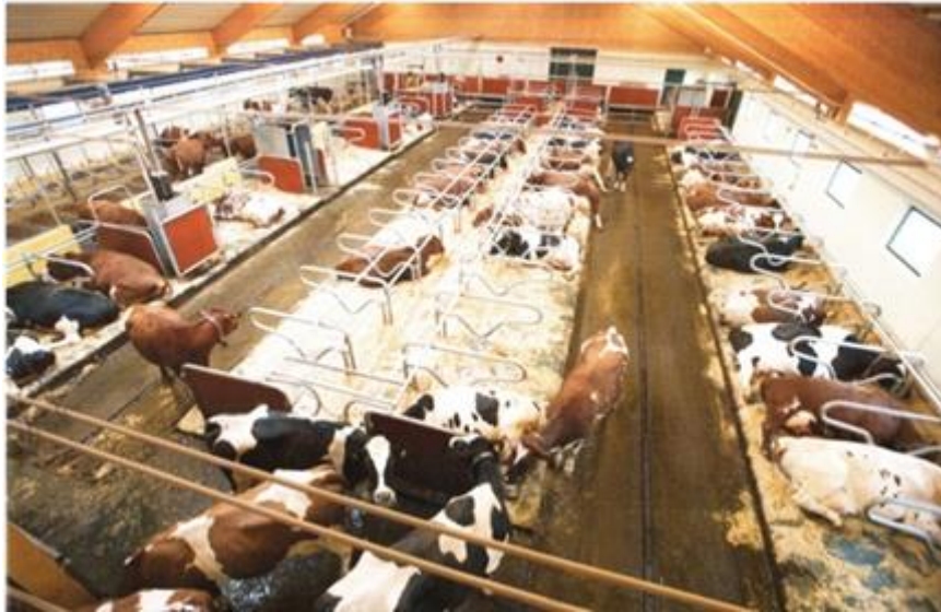
Рис. 1.9. Загальний вигляд обладнання УБК - 1 в приміщенні корівника
