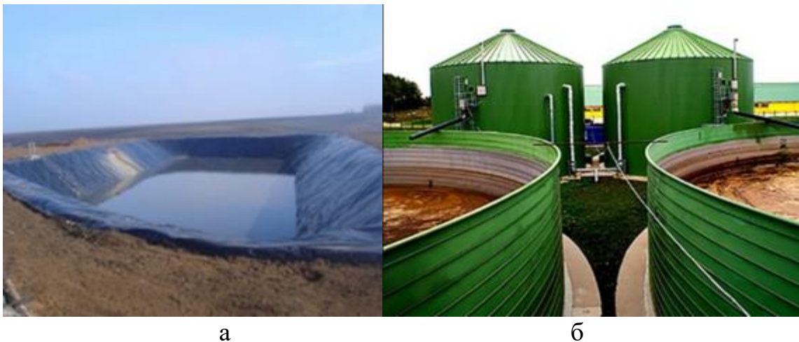
Рис. 20. Споруди для відстоювання рідкого гною типу лагуна (а) та гноєнакопичувачі (б).
